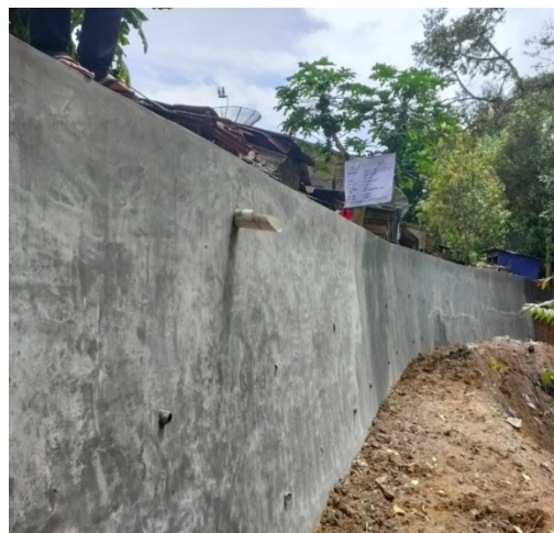
Foto dokumentasi pembangunan Tembok Penahan Tanah
